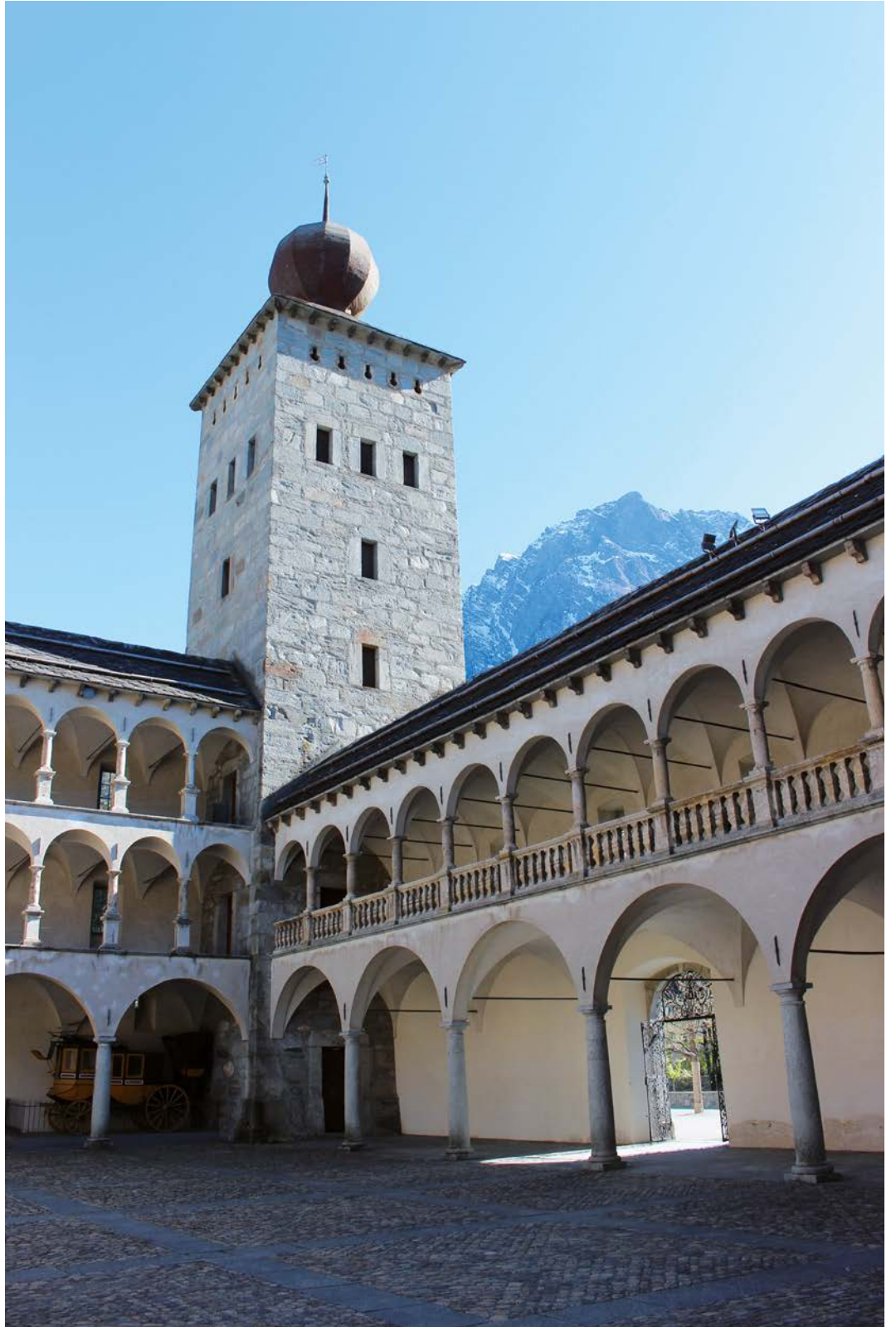
Der Innenhof des Stockalperschlosses in Brig zeugt von Arkaden im italienischen Stil der Renaissance. Der Schlosskeller wird der Austragungsort der 60. Generalversammlung. La cour intérieure du château Stockalper à Brig présente des arcades dans le style italien de la Renaissance. La cave du château sera le lieu de tenue de la 60e assemblée générale.
